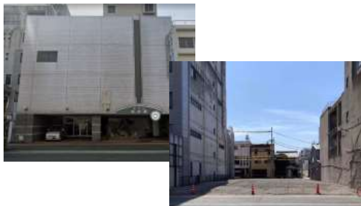
古くなったホテルを撤去し新たなホテルを建設
