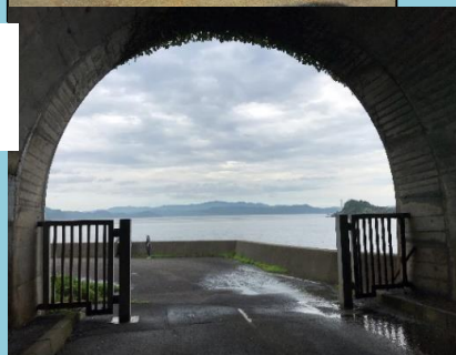
管理用 トンネル
