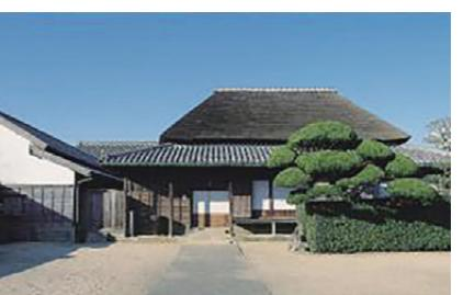
主屋の大きな茅葺き屋根は吉野川が氾濫して万が一の際に船代わりに水に浮くよう設計されている。
